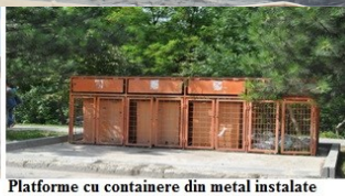
Platforme cu containere din metal instalate
