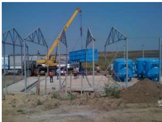
Montarea utilajului stației de tratare, anul 2013
