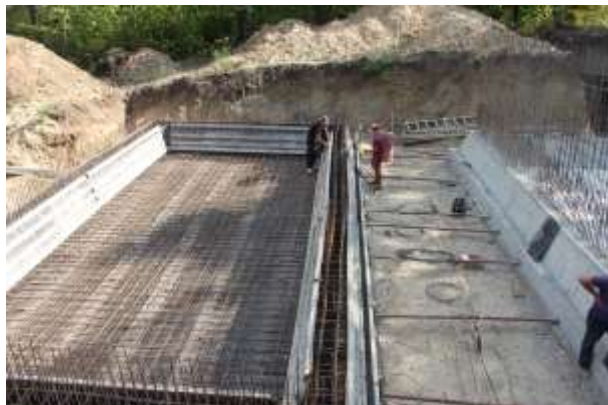
Construcția rezervoarelor de apă potabilă cu V=200 m.c fiecare, s.Unțești, anul 2014
