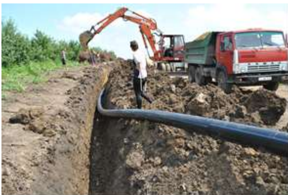
Montarea aducțiunii spre stația de tratare, anul 2013
