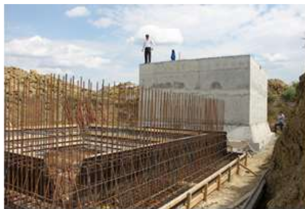
Construcția rezervoarelor cu V=100 m.c fiecare, s.Alexeevca, anul 2014
