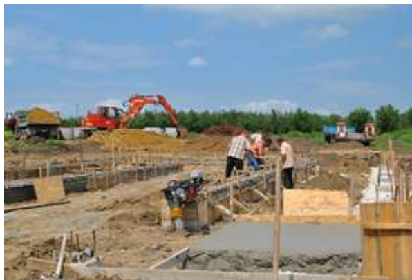
Lucrări de construcție a platformei de fundație pentru stația de tratare, anul 2013
